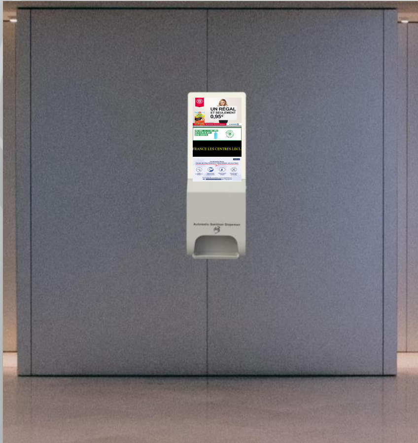
INSTALLATION HALL D'ENTREE
